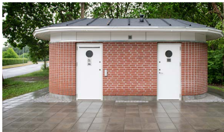
Ny toiletbygning ved Lergravsparken.
